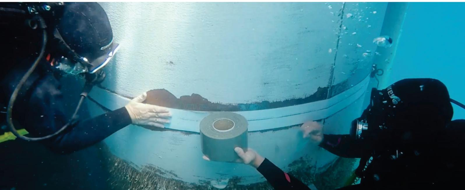
В зонах приливов и отливов покрытия Системы STOPAQ Splash Zone защищают от воздействия (соленой) воды, бактерий и кислорода.
