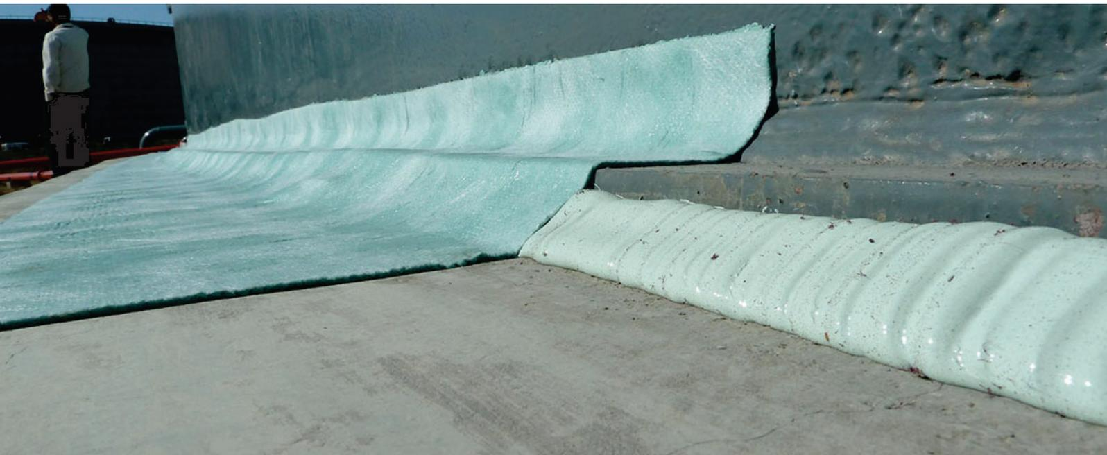
Антикоррозионная защита для любого инфраструктурного объекта. Благодаря решениям STORAQ все больше и больше кабелей передачи данных и силовых кабелей, кабельных соединений, осей подвижных составов, резервуаров для хранения, стальных конструкций и городских опор обеспечены гарантированной антикоррозионной защитой на весь срок их эксплуатации.
